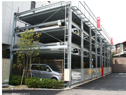
機械式駐車場
