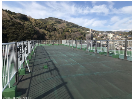
屋上洗濯物干しスペース
