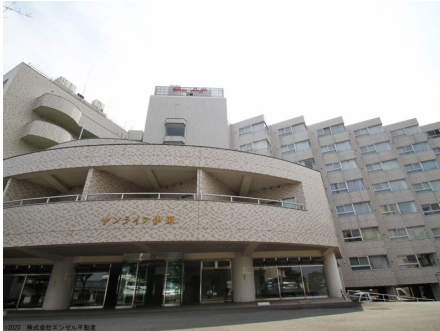
マンション全体
