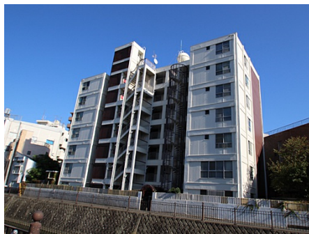
逗子葉山駅側からの外観
