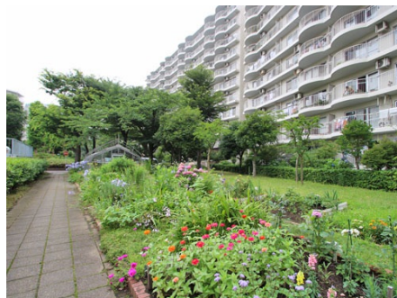
緑の多い敷地内
