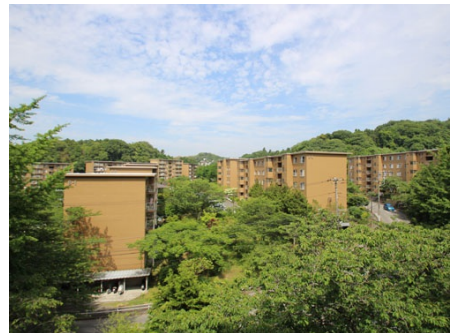
マンション全体
