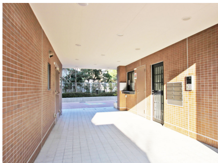
オートロックエントランス
