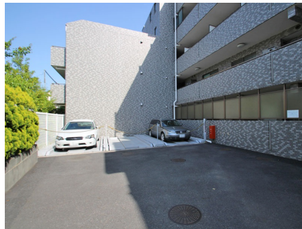
機械式駐車場
