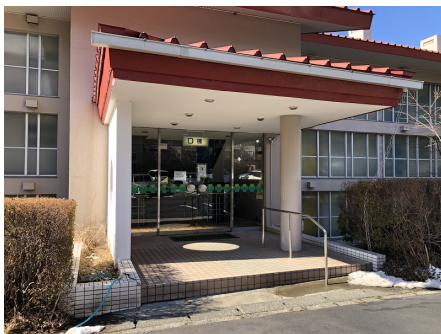
D棟エントランス
