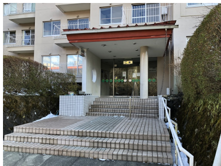
C棟エントランス
