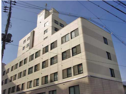
外観 (温泉街沿い)
