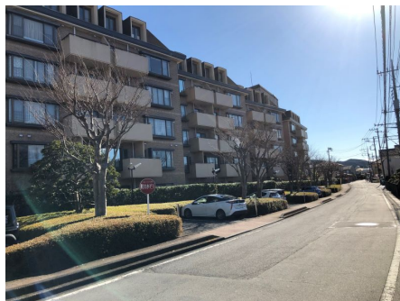
外観と前面道路
