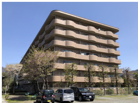
外観 南西側より
