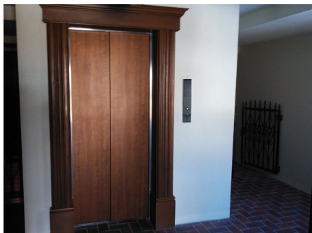
エレベーター（各棟に4基ずつ）
