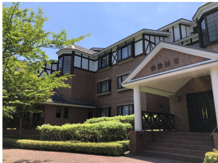
外観（1番館・エントランス側）
