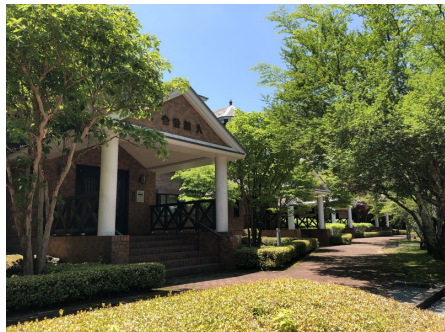
外観（1番館・エントランス側）
