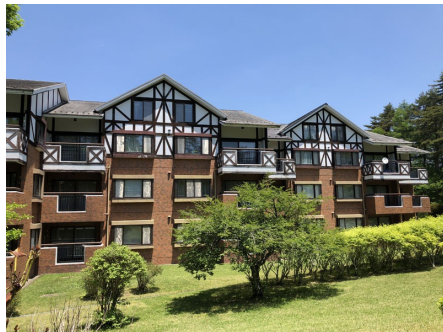
外観（1番館・南西側より）
