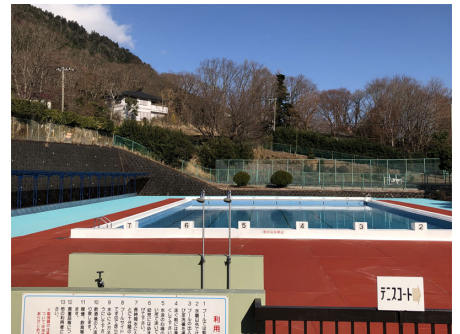
別荘地内施設 屋外プール
