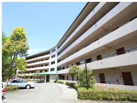
進入路路からの撮影
