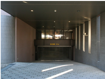
地下駐車場入口
