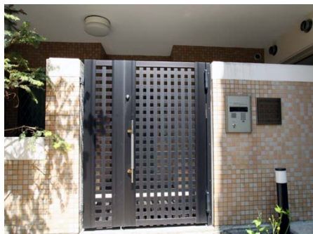
棟別のオートロック
