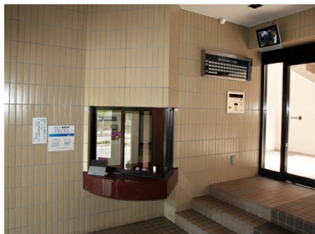
マンションフロント
