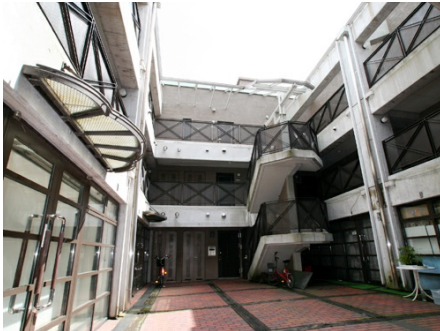
吹き抜け部分
