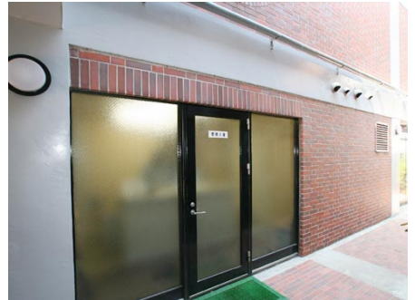
フロントエントランス
