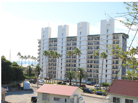
A棟の外観
