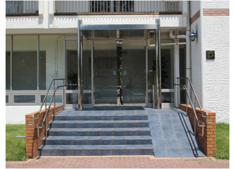
マンション入口（オートロック）
