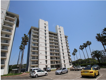
駐車場から見た外観
