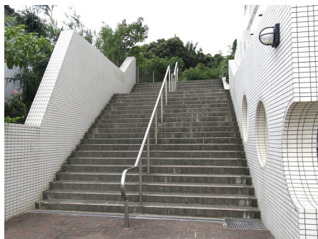
建物正面の階段
