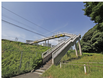
長沢駅に向かう歩道橋
