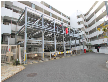
機械式駐車場
