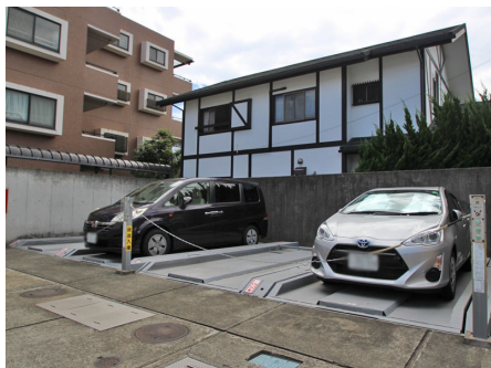
機械式駐車場
