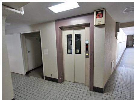
エレベーター
