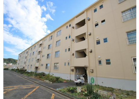
入口側からの外観
