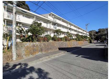
マンション前面道路
