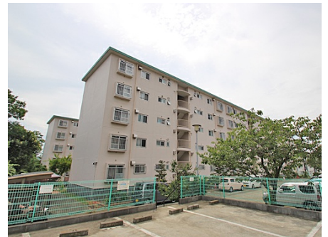
駐車場からの外観
