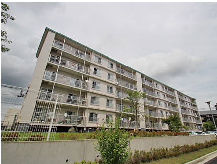
道路側からの外観
