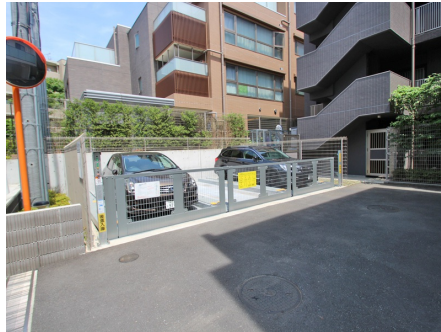
機械式駐車場
