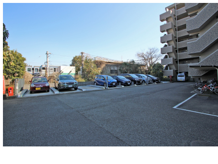
機械式駐車場
