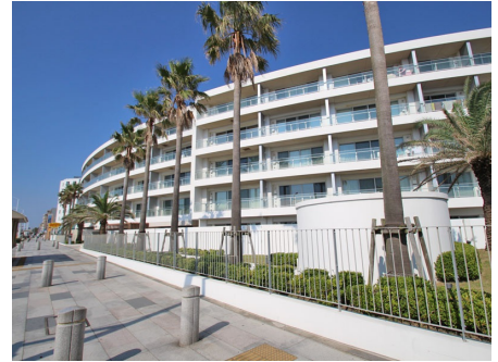
外観と前面の歩道
