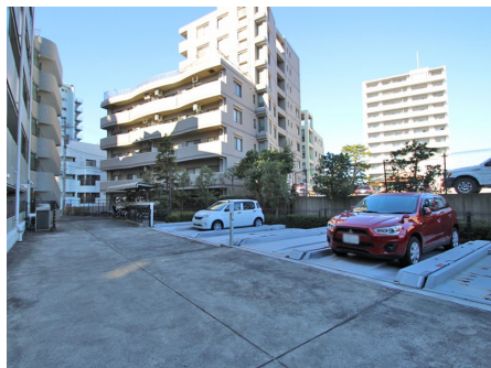
屋外機械式駐車場
