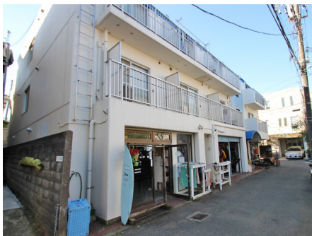
1階にはテナント
