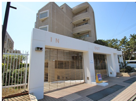
地下駐車場入口
