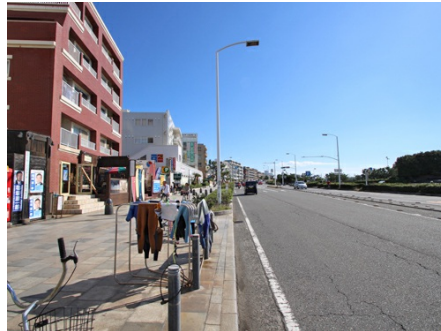
国道134号線とマンション
