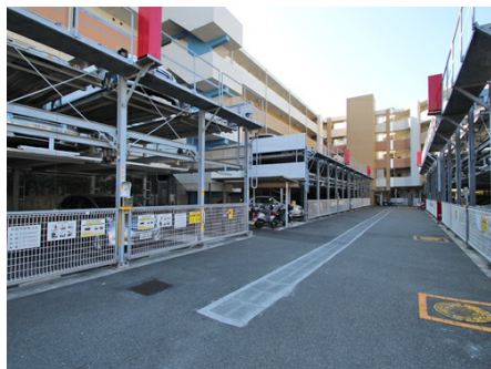
機械式駐車場
