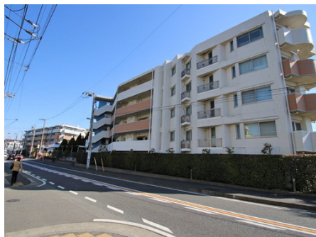
国道467号線側からの外観
