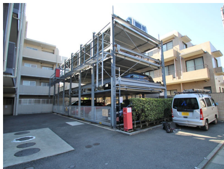
機械式駐車場
