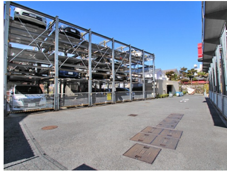
敷地内の機械式駐車場
