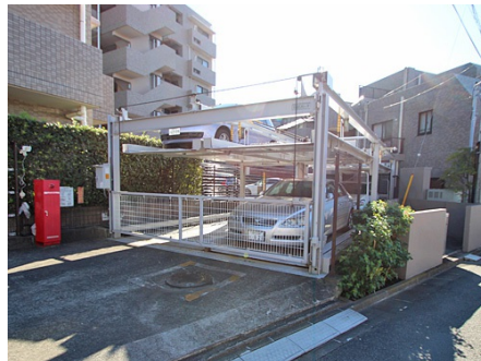
機械式駐車場
