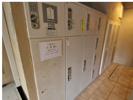
宅配ボックス
