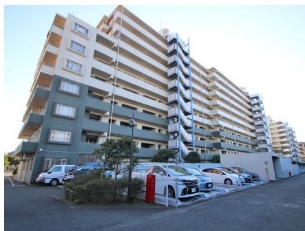
駐車場側からみた外観
