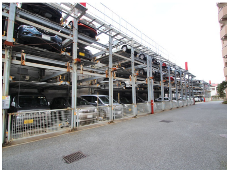
機械式駐車場
