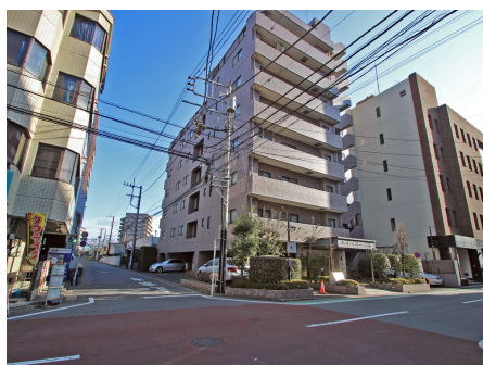
マンション前面道路
