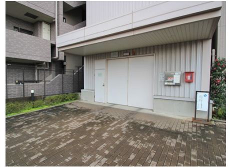
機械式駐車場
