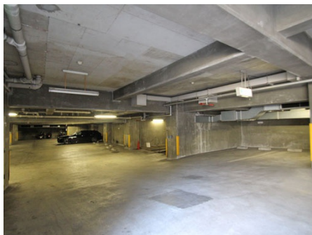
屋内地下駐車場
