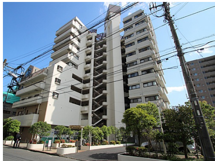
北東側から見た外観
