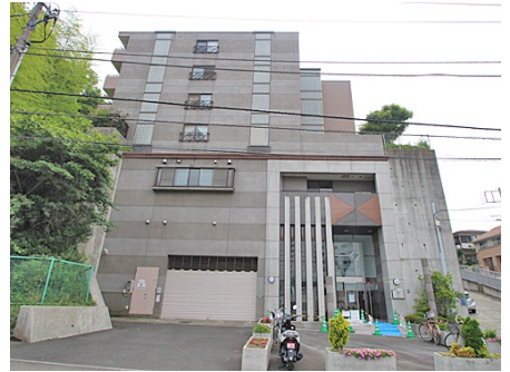
マンション入口正面
