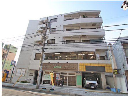
1・2階はテナント
