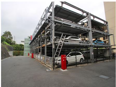
機械式駐車場
